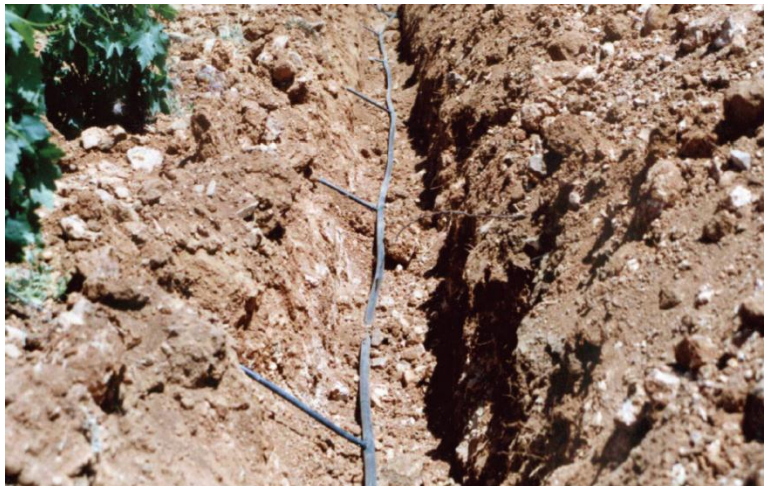
Figura 3.20 - Instalação do sistema subterrâneo no campo (Fonte: López, 2013)
