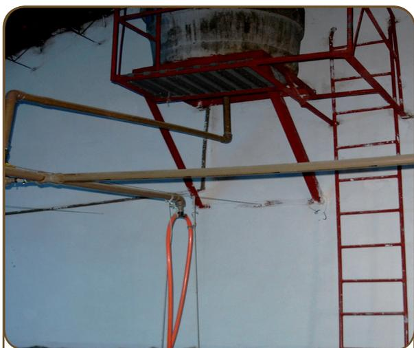
Figura 18: Caixa d'água para medicação.
