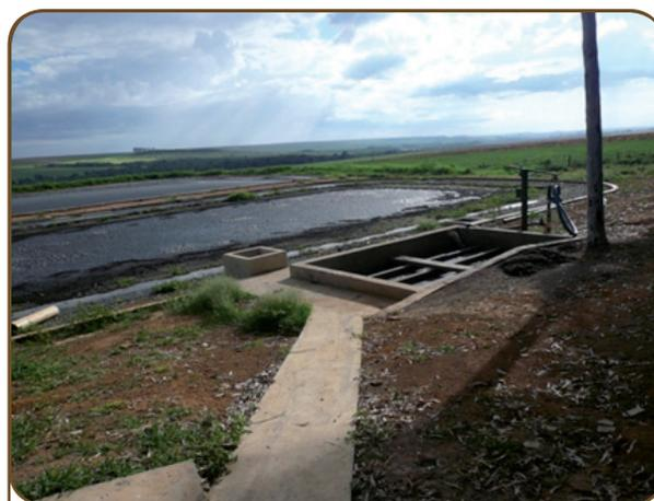
Figura 3: Decantador de dejetos, com lagoas de estabilização ao fundo.
