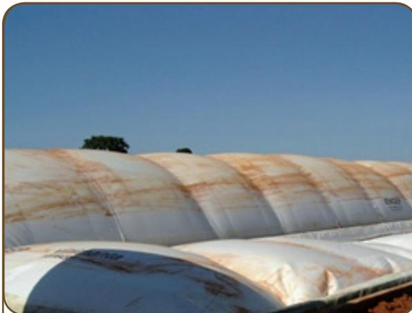
Figura 7: Biodigestor em lona de PVC.
