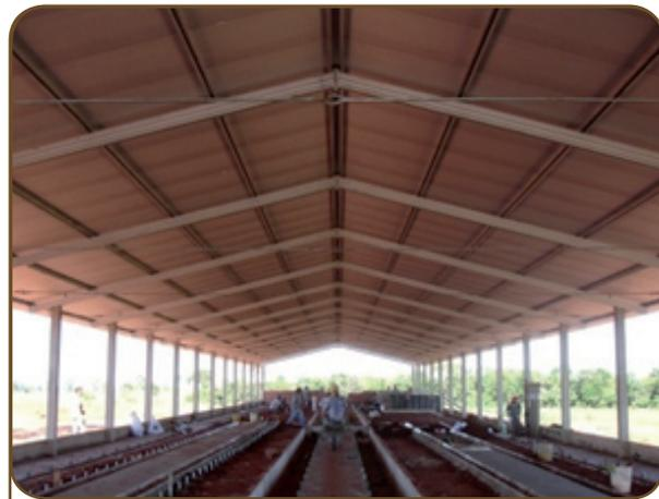
Figura 8: Telhas térmicas (poliestireno).
